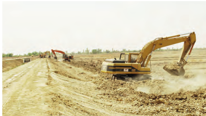
EDSECG SARL a pris la relève dans l'exécution des travaux d'aménagement
