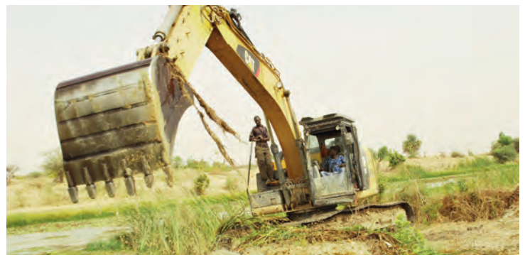
Les travaux concernent le réseau d'irrigation et de drainage de 500 hectares du casier de Tiogoni et l'aménagement d'une partie du drain de Kalankorola
