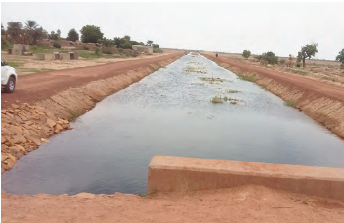
Beaucoup d'aménagements pour l'extension des superficies ont été réalisés ou réhabilités
