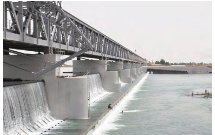
Le barrage de Markala joue un rôle primordial pour réguler le débit de l'eau
